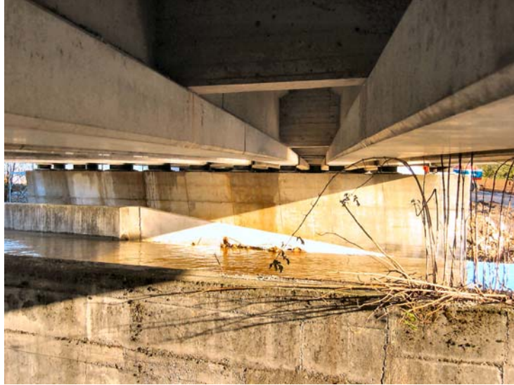
Şekil 2- Roggia Borgogna Köprüsü'nde uygulanan elastomer mesnet elemanları, İtalya
