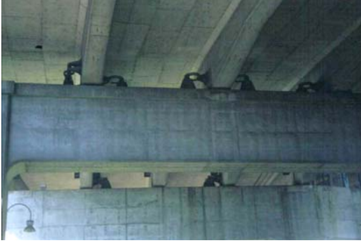
Şekil 5-Garnville köprüsüne monte edilmiş, hilal şeklinde elamanları bulunan çelik histeretik sönümleyiciler (solda) ve bu tip sönümleyicilere ait tipik bir kuvvet-deplasman deneysel eğrisi.
