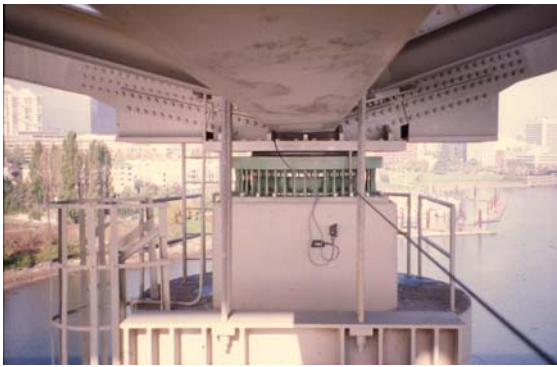
Şekil 10-Marquam Köprüsünde uygulanan çelik histeretik dağıtıcılarla birlikte kayıcı mesnet elemanları, Oregon, ABD (solda) ve Chirag I deniz a°ırı platformunda kullanılanlar (sağda).
