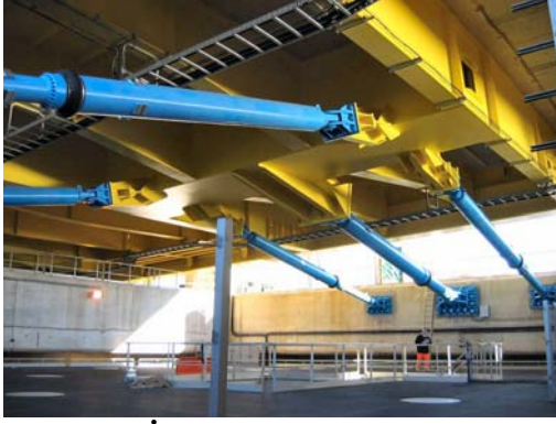
Şekil 12- İtalya menşeli akıcı vizkoz sönümleyicilerin uygulama örnekleri: Rion Antrion ana köprüsü, Yunanistan (solda) ve Seohae Köprüsü, Kore (sağda).
