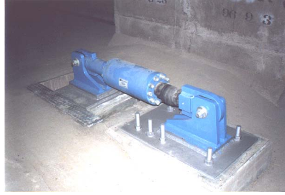
Şekil 12- İtalya menşeli akıcı vizkoz sönümleyicilerin uygulama örnekleri: Rion Antrion ana köprüsü, Yunanistan (solda) ve Seohae Köprüsü, Kore (sağda).
