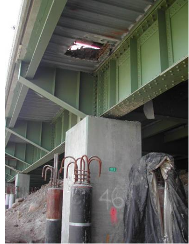
Şekil 6. Yapımı Tamamlanmış Fore Kazıklar
