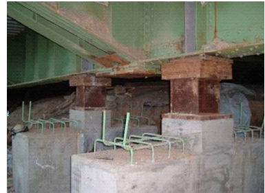
Şekil 7. Üst Yapının Bağ Kirişleriyle Desteklenmesi
