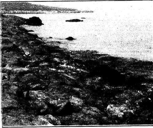
Resim-4 Tahkimat Görünüşü
