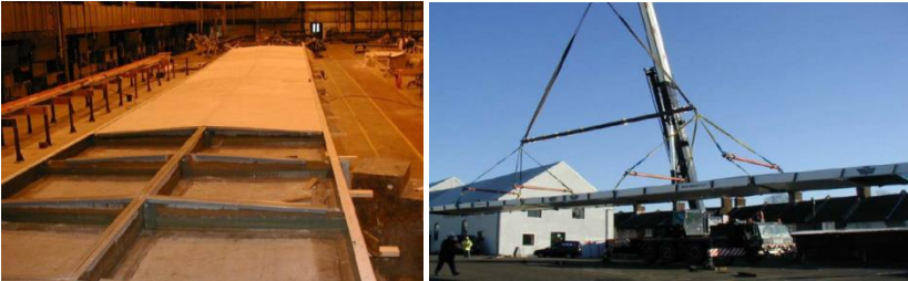
Şekil 4. Halgavor asma yaya köprüsü tabliyesi [URL-3]
