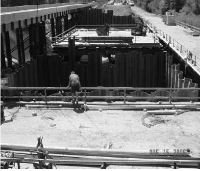
Şekil 4. Palpaş batardo teşkili ile köprü temeli kazı çukurunun korunması (Oregon Department of Transportation-ODOT, 2014)
