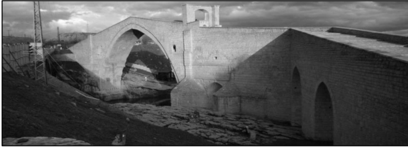
Resim 8. Restorasyon Sonrası Köprünün Görünümü.
