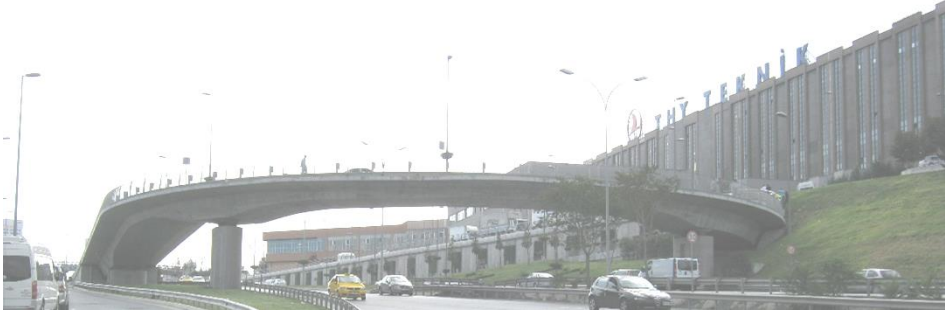
Şekil 5. Değişken kesitli yerinde dökme ardgermeli sürekli tabliye köprü, Atatürk Havalimanı.
