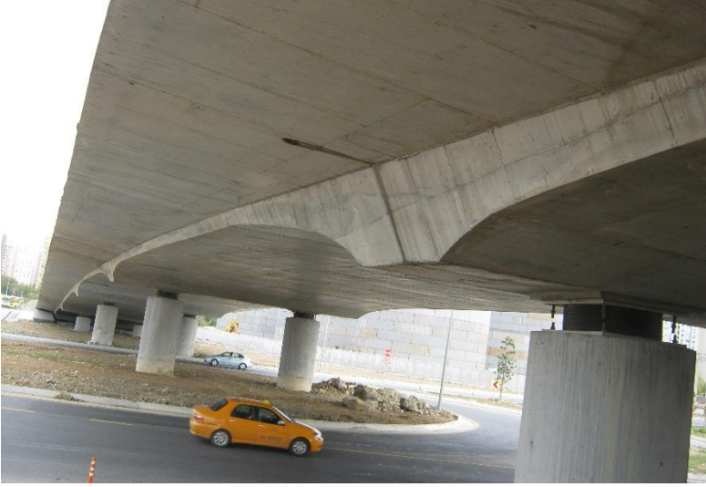
Şekil 14. Atatürk Havalimanı Köprüsü tamamlanmış hali.
