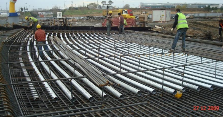
Şekil 13. Eğri eksenli ardgerme kılıflarının yerleşimi.
