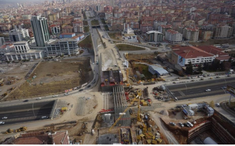
Şekil 10. Ankara Melikşah Köprüsü yapım aşaması.
