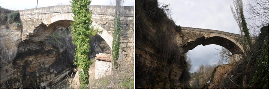
Şekil 1. Dandalaz Köprüsü'ne ait bazı görünüşler
