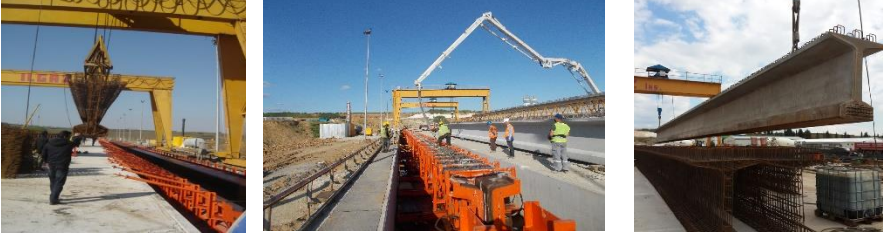
Fotoğraf 23, 24, 25. Meriç Köprüsünde kullanılacak öngermeli kiriş üretimi.
