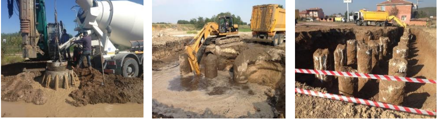
Fotoğraf 14, 15, 16. Fore kazık yapımı.
