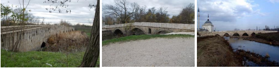
Fotoğraf 7, 8, 9. Yıldırım Köprüsü, Fatih ( Bönce ) Köprüsü, Beyazıt Köprüsü.
