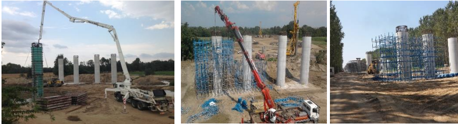
Fotoğraf 20, 21, 22. Meriç Köprüsü inşaatında elestasyon yapımı.
