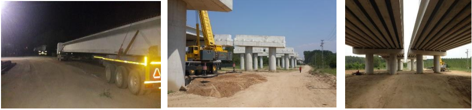
Fotoğraf 26, 27, 28. Meriç Köprüsünde öngermeli kiriş montaj çalışmaları.
