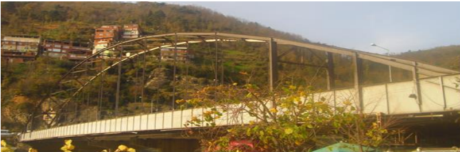
Şekil 7. Borçka Çelik Kemer Köprüsü
