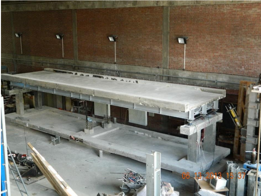
Şekil 1. Köprü genel görünüşü
