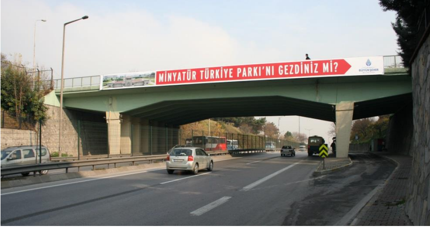
Şekil 1.2. Köprü mevcut durum görünümü.
