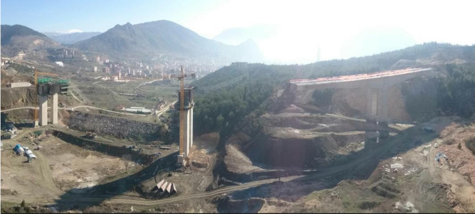
Şekil 9. Şehzadeler Viyadüğü inşaat sırasında genel görünüşü.
