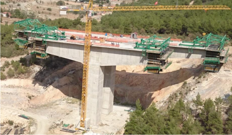
Şekil 2. Şehzadeler Viyadüğü dengeli konsol kalıp sistemi.
